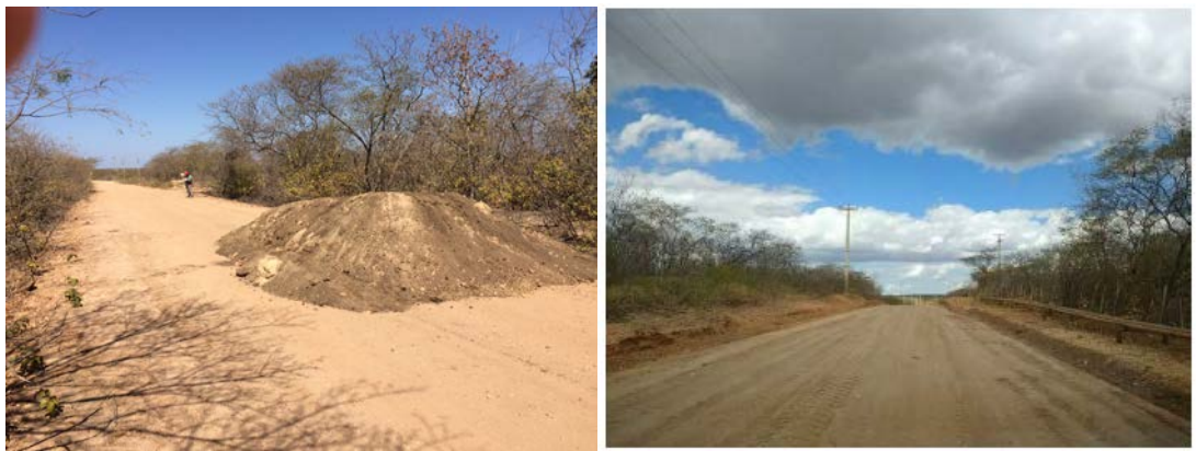
Figura 2. Imagens representando o antes e depois do trecho requalificado.
